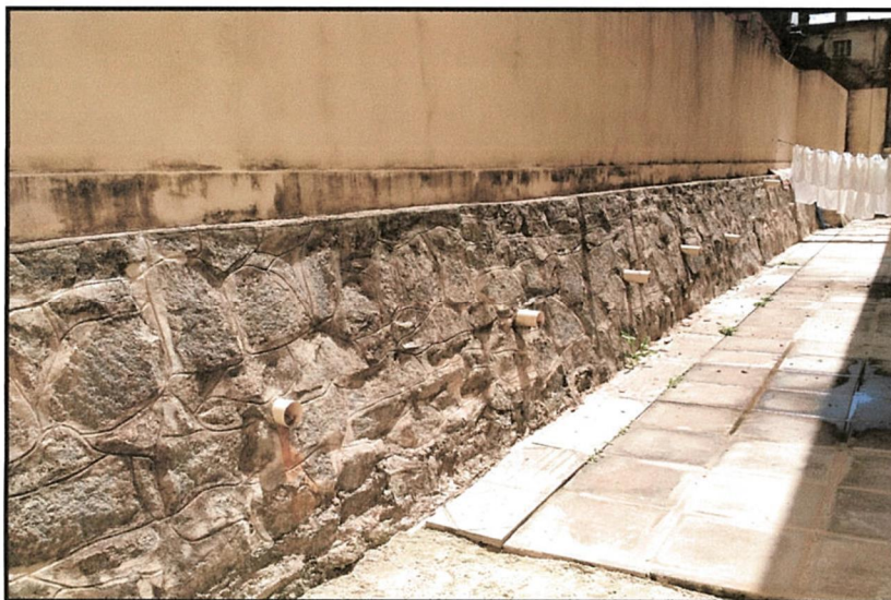
Figura 1:Foto do Muro de arrimo no Creche - Escola 8 de Março, Ibura.
