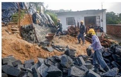
Foto 5.3 - Muro de arrimo de pedra rachão. Fonte Acervo da Emlurb 2017.
