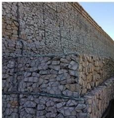
Foto 5.4 - Muro de arrimo de gabiões.
