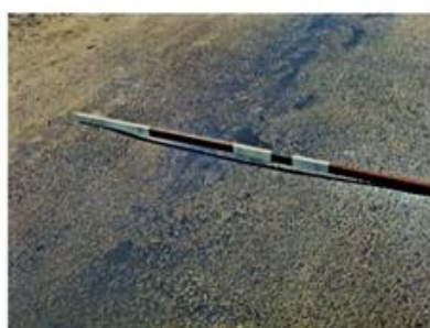
Figura 3.10 - Afundamento consolidado local. Fonte: DNIT 2003.
