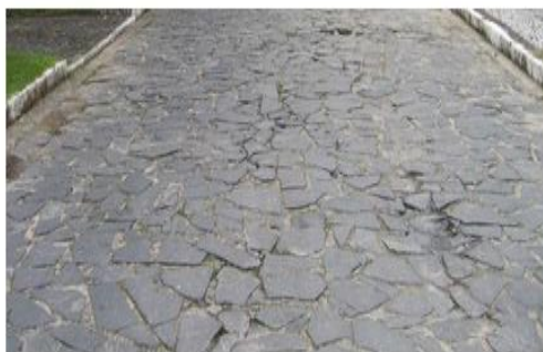
Figura 3.2 - Calçamento em pedra irregular.
