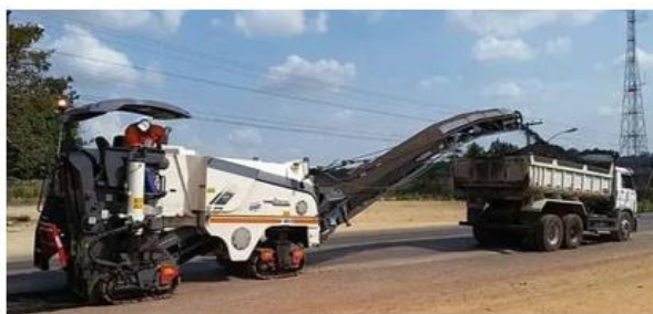
Figura 3.16 - Fresadora em operação com elevação do material fresado para caminhão basculante.
