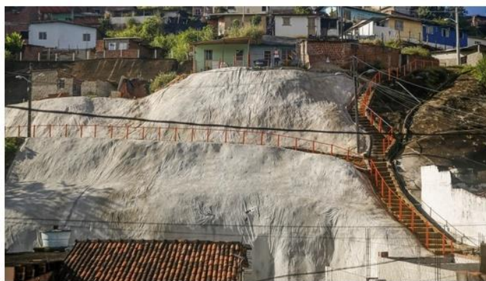
Foto 5.5 - Aplicação de geomanta. Fonte: Acervo de andréa Rêgo Barros/PCR.
