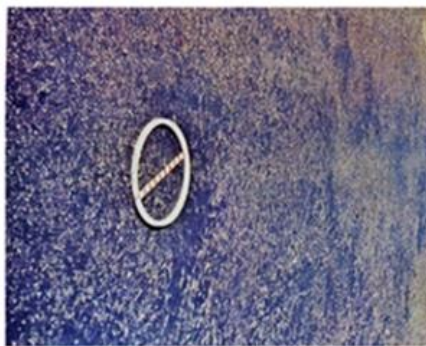
Figura 3.13 - Exsudação. Fonte: DNIT 2023.
