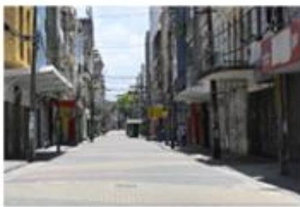
Figura 3.4 - Pavimentação em blocos de concreto intertravados.
