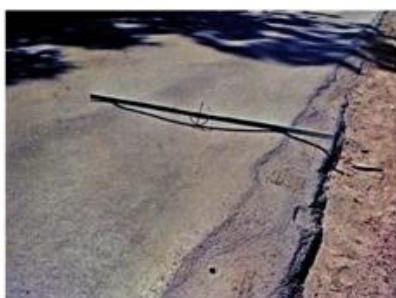
Figura 3.9 - Afundamento de trilha de roda. Fonte: DNIT 2003.
