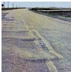
Figura 3.11 - Ondulação. Fonte: DNIT 2003.
