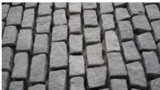
Figura 3.1 - Disposição dos paralelepípedos na faixa de rolamento espaçados pela junta de 2 cm.
