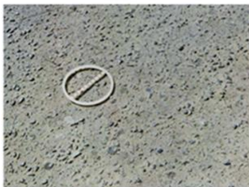
Figura 3.14 – Desgaste. Fonte: DNIT 2003.
